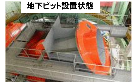
ベント管および コンクリートスリーブ部(縦置き)
