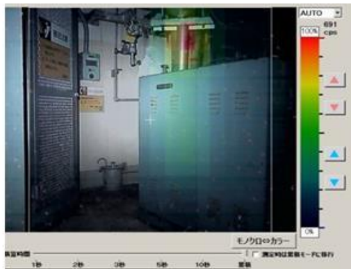
図 撮影位置①(壁側撮影)
