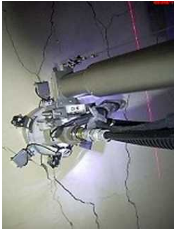
ドライアイスブラスト除染状況
