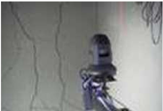
壁面のひび割れ状況
