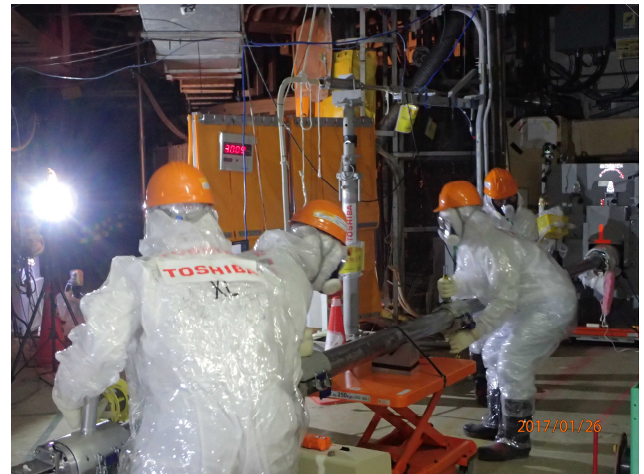
【2号機原子炉建屋内】
