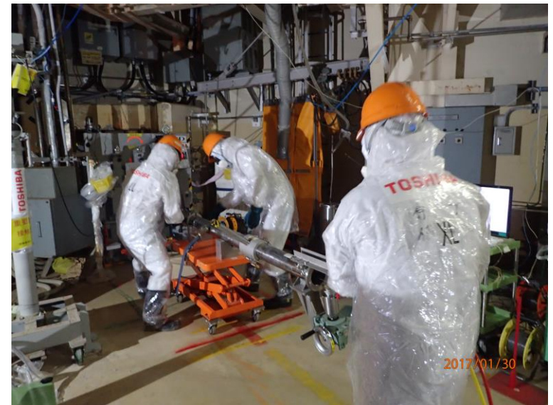
【2号機原子炉建屋内】
