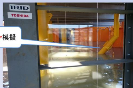
工場試験(コンクリート打設中)
