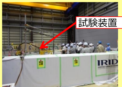
試験棟内（作業フロア上）
