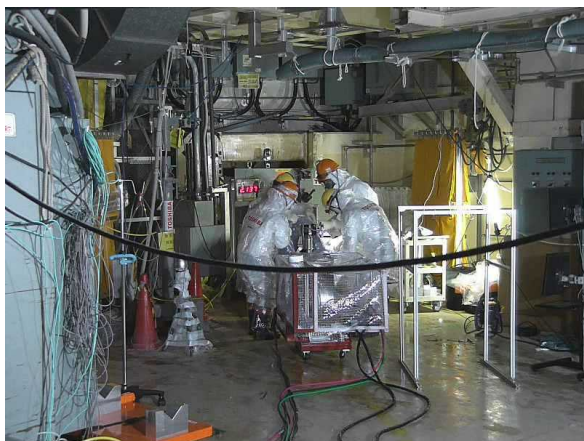
PCV外部（X-6ペネ）前での作業
