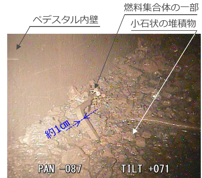
撮影場所C ペDESTAL底部
