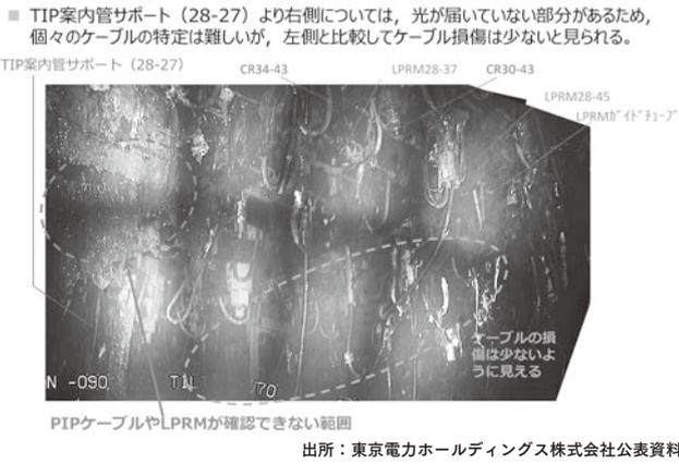
図6 2号機 PCV 内部調査結果（ペDESTALプラットフォーム上部）
