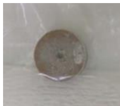
コンクリートコア外観 (4RB-1F-C-E2)
