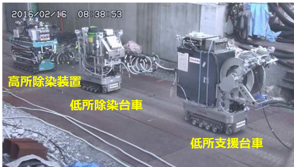
3号機R/B内への進入風景
