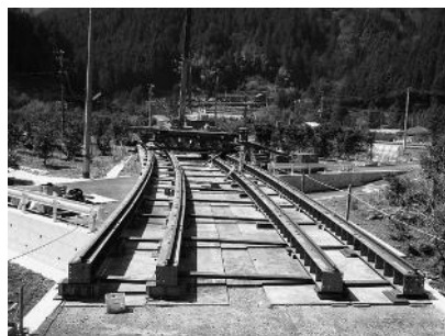
送り出しレールを曲げている例
