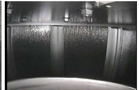
写真② 模擬吸着塔の側面状況 (内視鏡:側視遠点)
