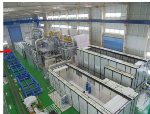
大型機器除染設備外観
