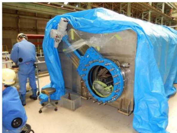
エンクロージャ養生除去作業状況
