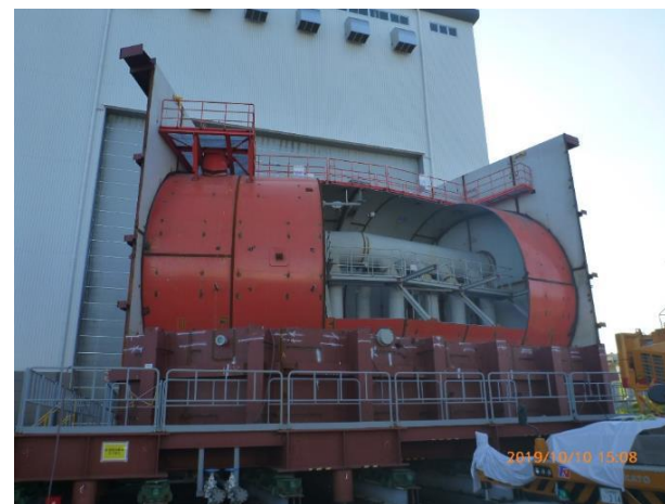
内部確認（解体）
