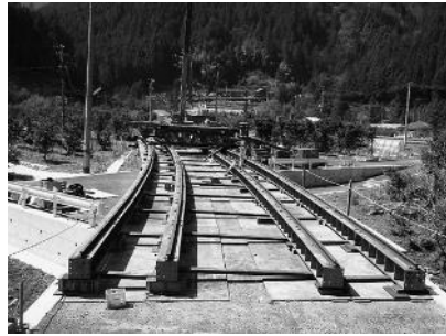
送り出しレールを曲げている例
