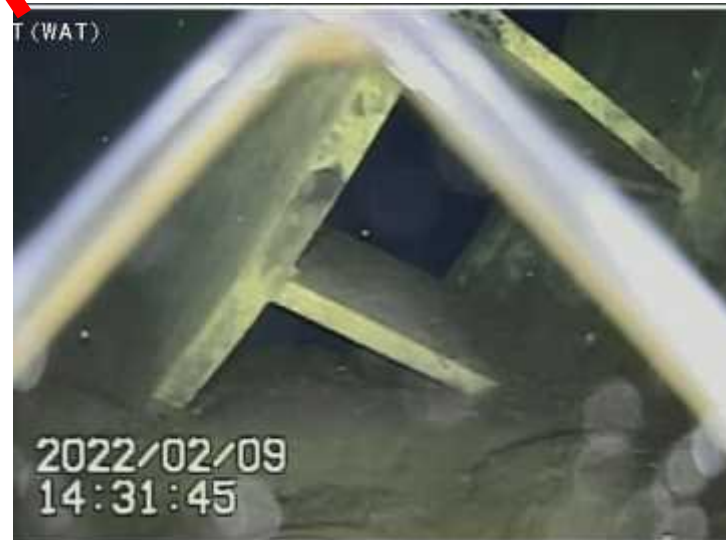
PCV東北東付近の状況 (近接)
