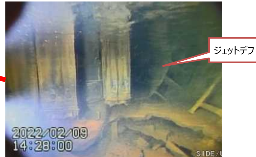
PCV東北東付近の状況(俯瞰)
