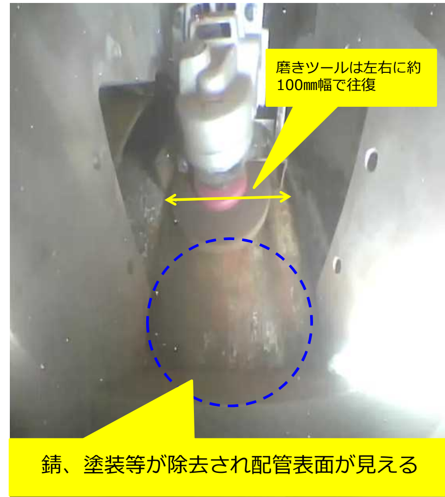
X-6 ペネ配管磨き状況（磨き装置ケーシング内写真）
