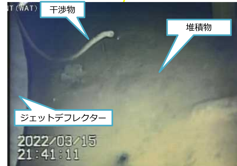
写真3. ジェットデフレクター(G)底部付近の状況② 7
