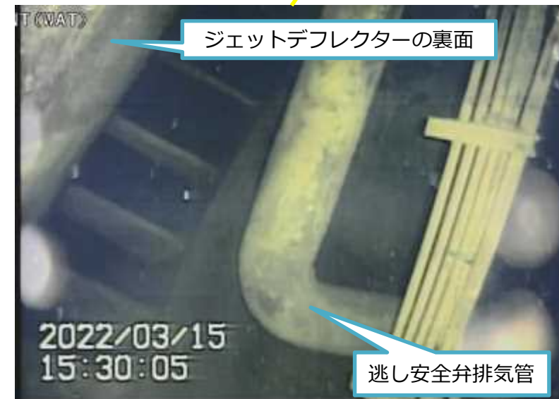
写真3.ジェットデフレクター(G)裏側の状況
