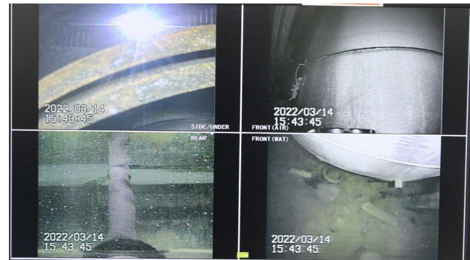
写真4.吊り下ろし地点での状況
