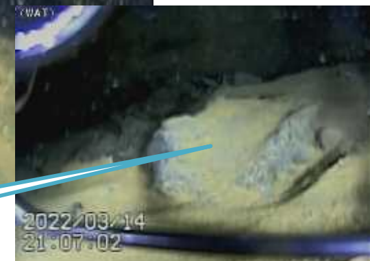
写真3. PLRポンプ(B)入口弁付近の状況
