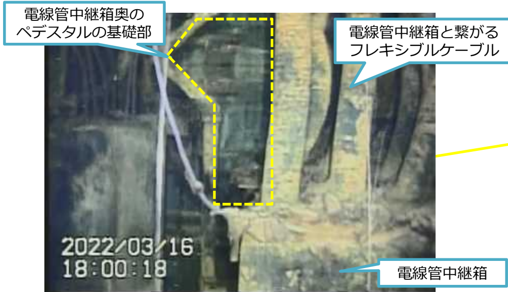
写真1.ペデスタル基礎部付近の状況①
