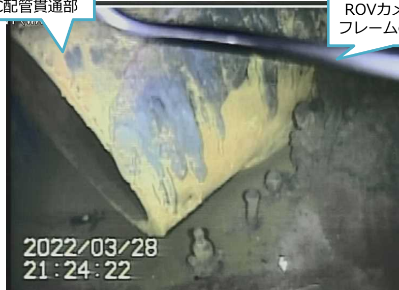
写真2.AC配管貫通部の状況
