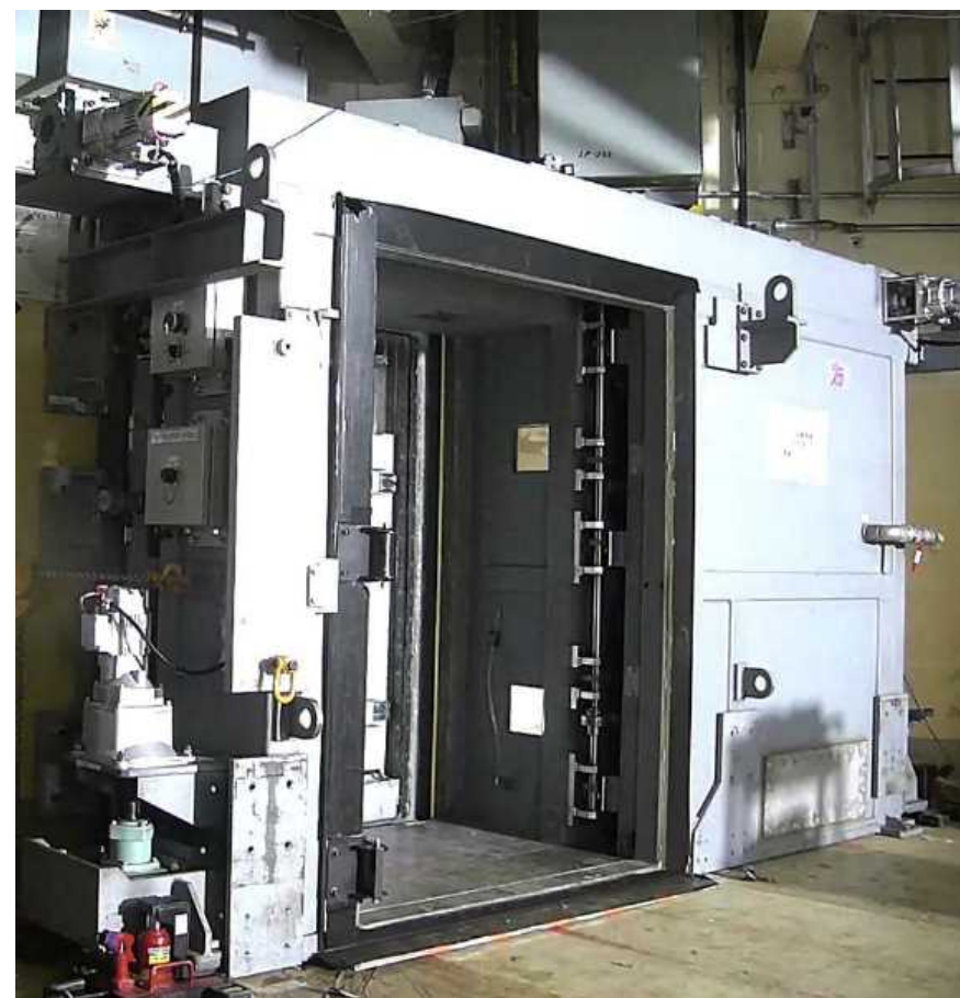
隔離部屋②の設置状況
