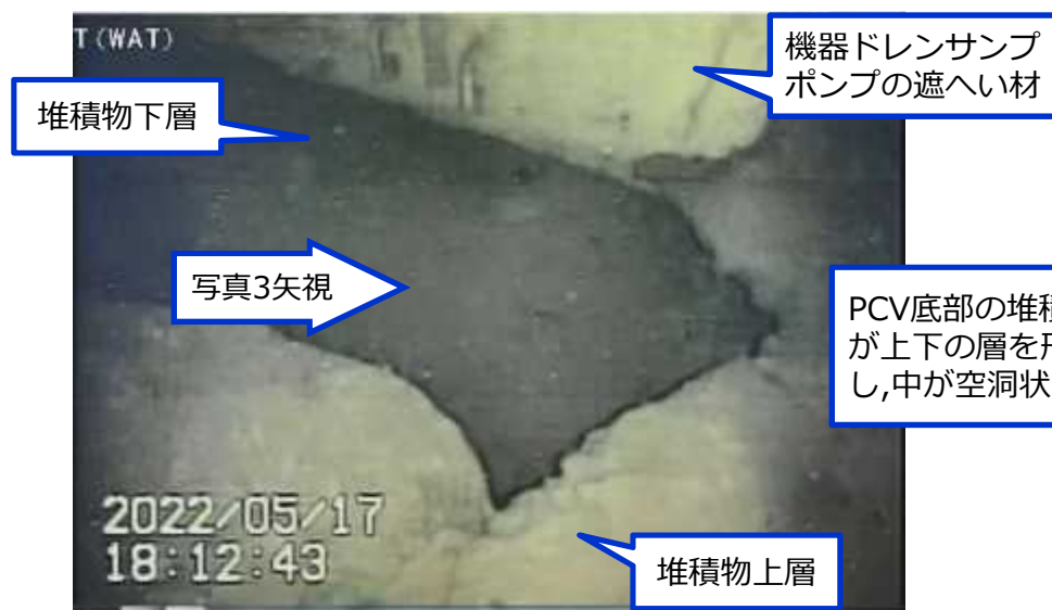
写真2.PCV底部の堆積物の状況
