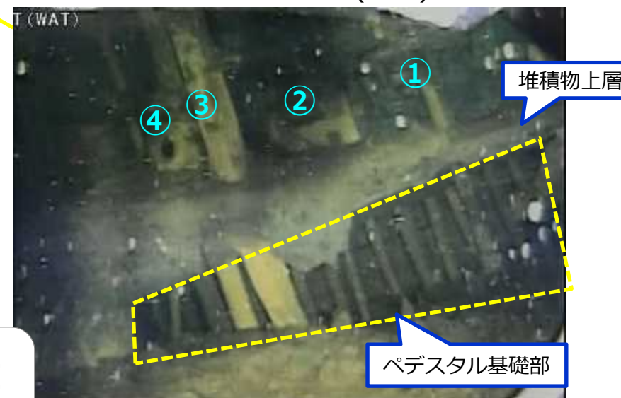
写真2.ペDESTAL基礎部(下部)の状況
