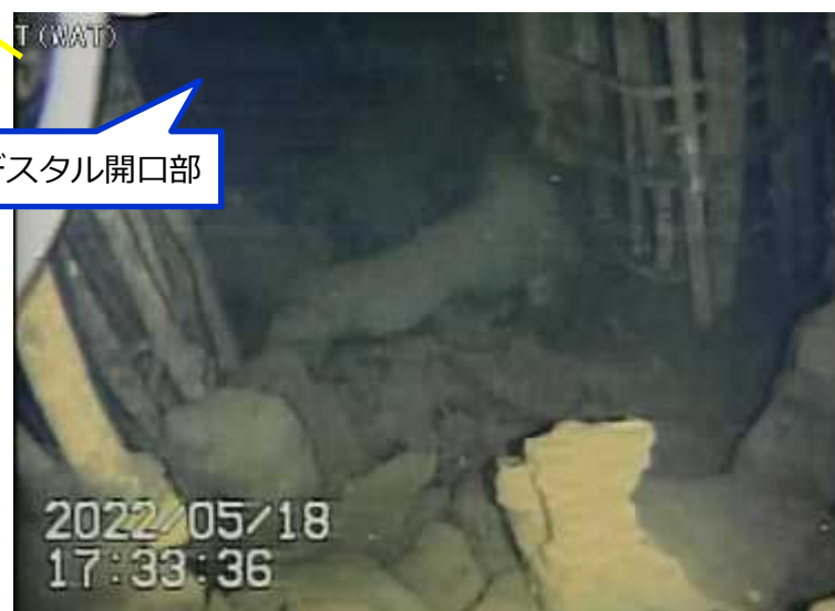
写真3.ペDESTAL開口部前の堆積物の状況
