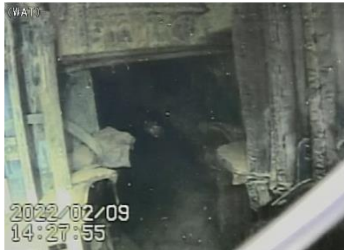
ペDESTル開口部付近
