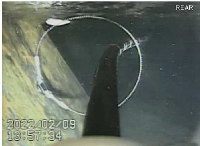
ガイドリング設置状況
