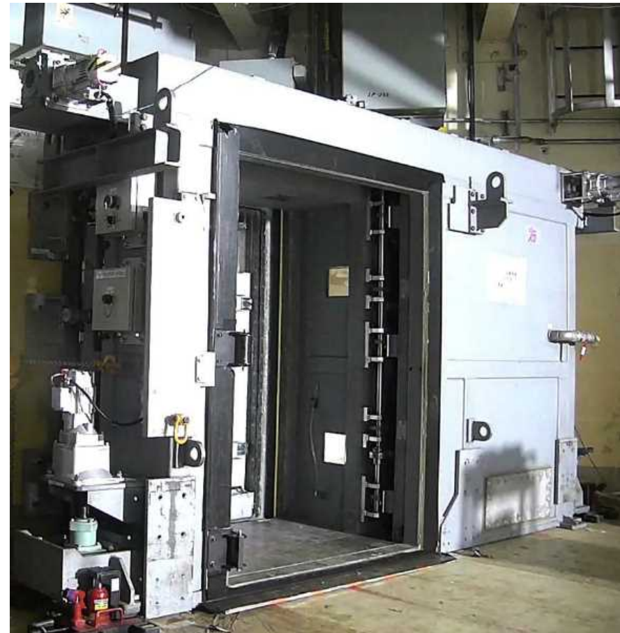
隔離部屋②の設置状況
