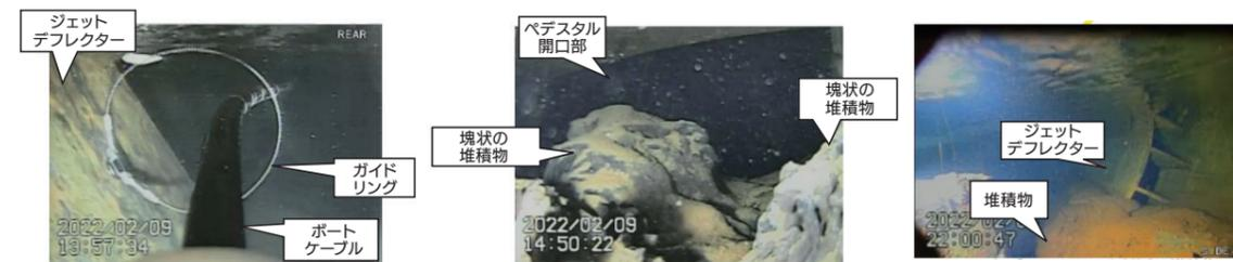
▲潜水機能付ポート【IRIDOLPHIN-A】によるガイドリング取り付け遊泳時の映像(図4-4)
