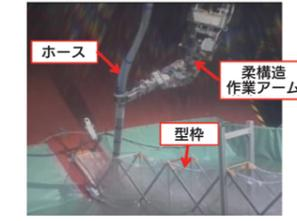
▲折り畳み式型枠へモルタル充填
