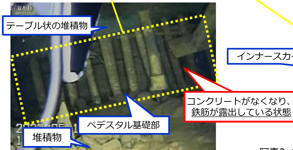
写真1.ペDESTAL基礎部付近の状況
