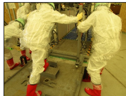
汚染拡大防止蓋の搬入
