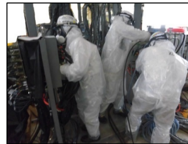
装置養生状況
