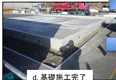
d. 基礎施工完了
