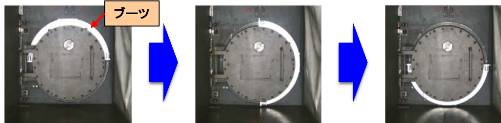
下段ブーツ取付けステップ
