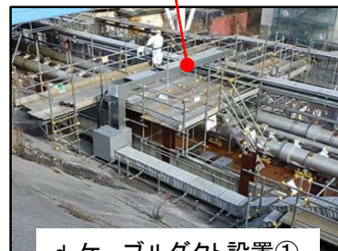
d. ケーブルダクト設置①
