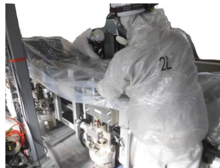
装置養生状況
