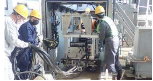
ハッチ開放装置設置(搬入中)
