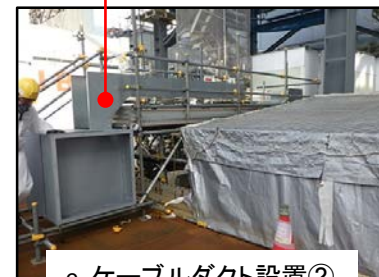
e. ケーブルダクト設置②
