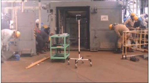
ハッチ隔離部屋設置(位置調整中)
