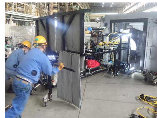
ブーツ搬送装置の取付けモックアップ状況
