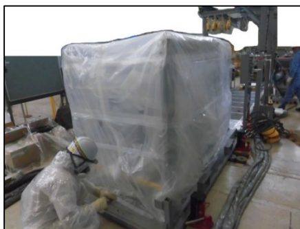
汚染拡大防止蓋状況
