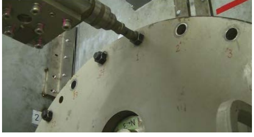
ペネハッチのボルト・ナット取外し
