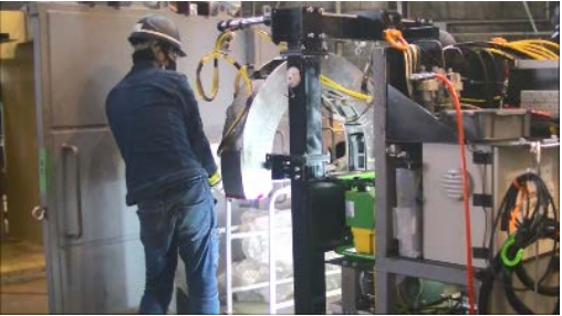
ペネ磨き(磨き装置設置中)
