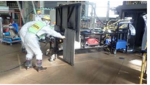
ブーツ設置(ブーツ搬送装置(設置中))
