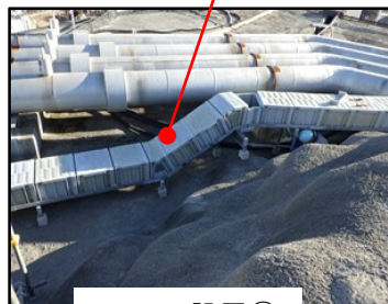
b. トラフ設置②
