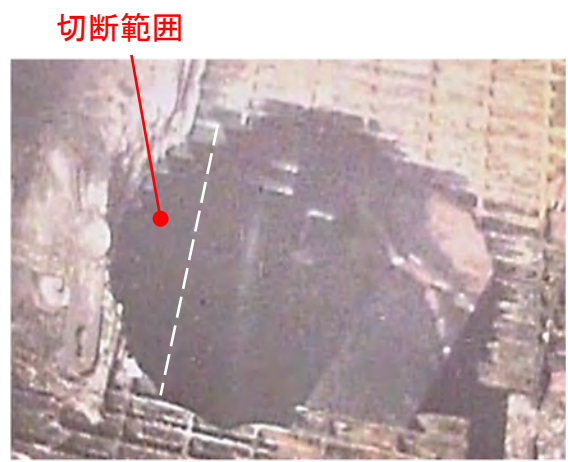
図4.1.2(1)(ii)-3 切断後の状態
