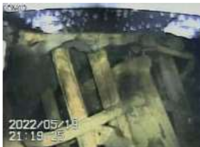
(1) ペDESTAL開口部(左側基礎部)
