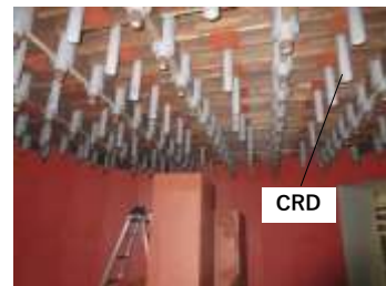
ベDESTAL内部の様子
