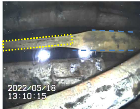
水面より上のRCW配管の状況
