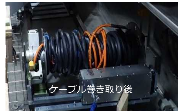
センサ・ツールの搬入出試験の状況（ケーブルドラム）
