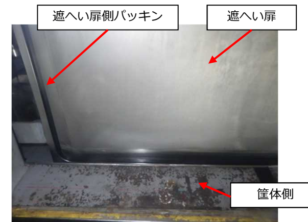
<扉側パッキン取付>
