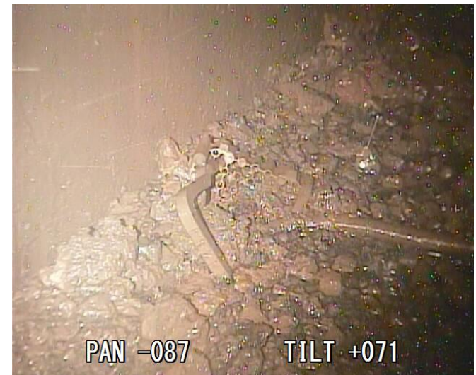
2号機格納容器内底部, ペDESTAL内 内壁付近
