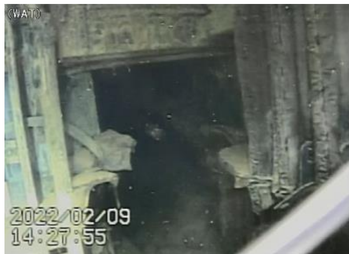
ペDESTル開口部付近
