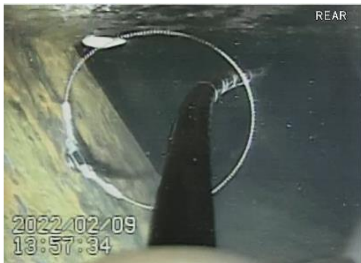
ガイドリング設置状況
