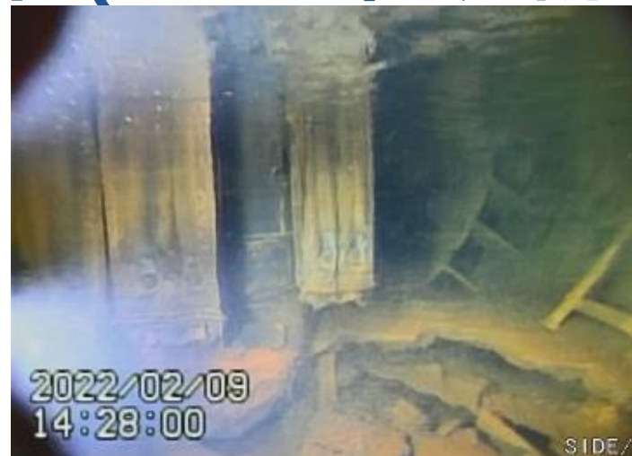
PLR配管付近
