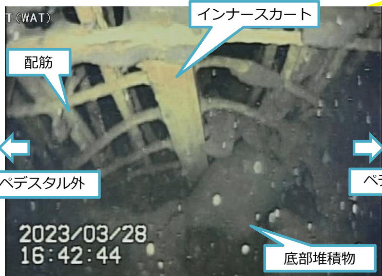
写真2.ペDESTAL開口左側配筋
