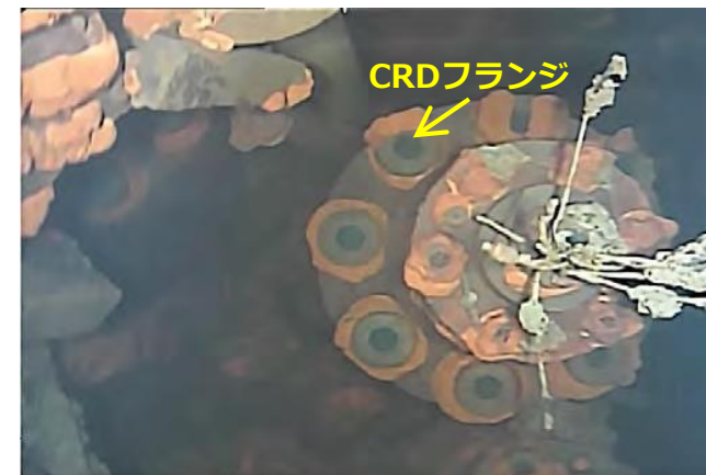
写真3. 3号機で確認されたCRD
