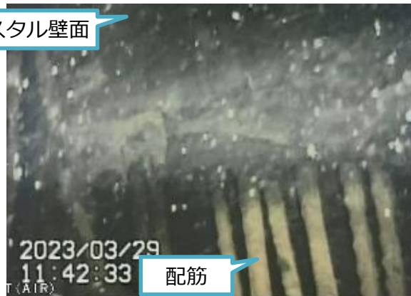
写真1. ポイント⑪ペDESTAL基礎部
