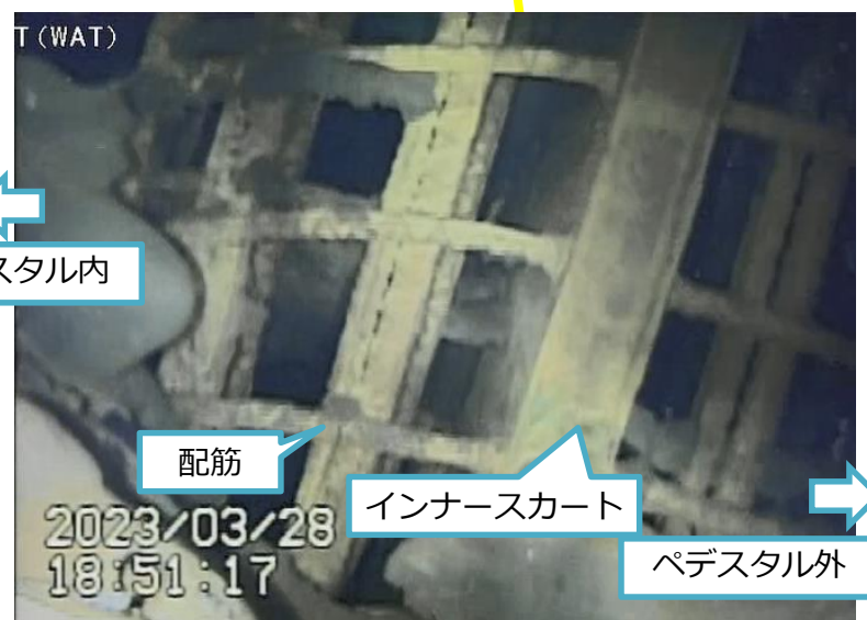
写真3.ペDESTAL開口右側配筋
