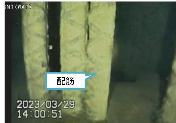
写真2. ポイント⑫ペDESTAL基礎部
