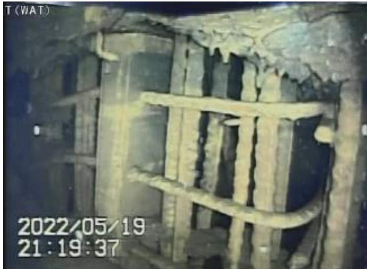
アクセス開口部付近 調査状況
