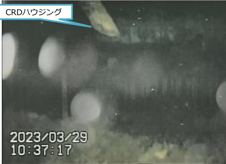
写真1 ペDESTAL内中心部で確認されたCRDハウジング（水中）
