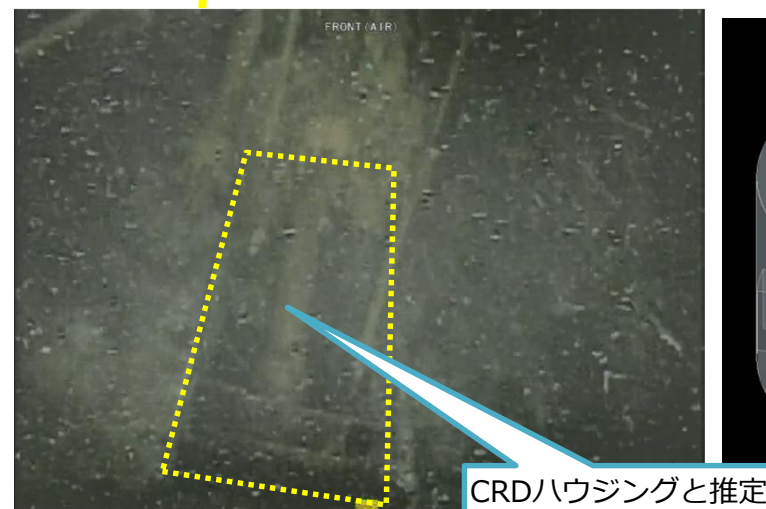
写真3. ペデスタル内壁側のCRD交換用開口部の状態
