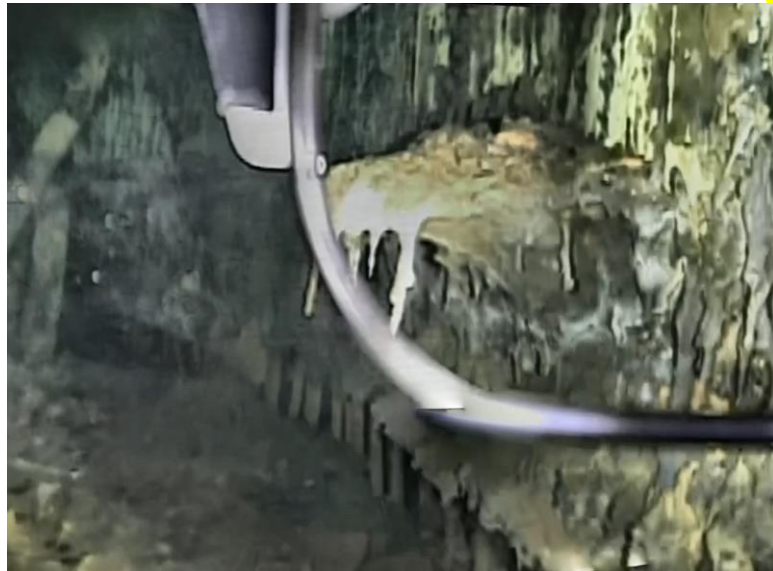
写真2 (パノラマ) 開口部右側の棚状堆積物
