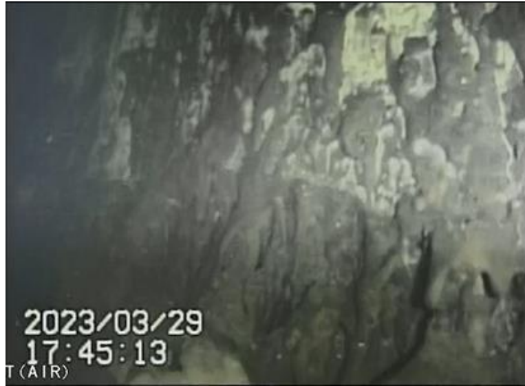
写真1 棚状堆積物のない壁面の状況
