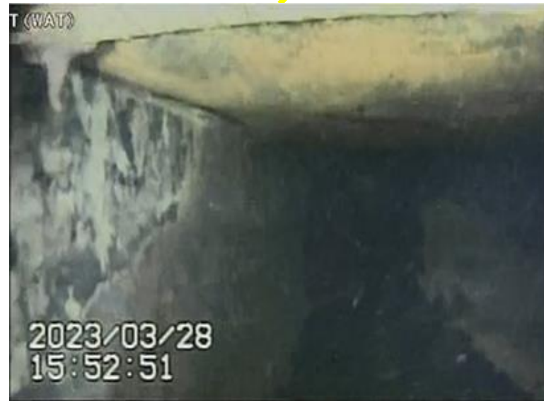
写真3 開口部内部の左側の壁の状態
