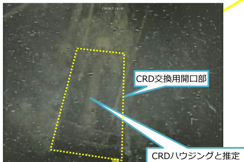
写真2. ペデスタル内壁側のCRD交換用開口部の状態 (気中監視カメラで気中を撮影)
