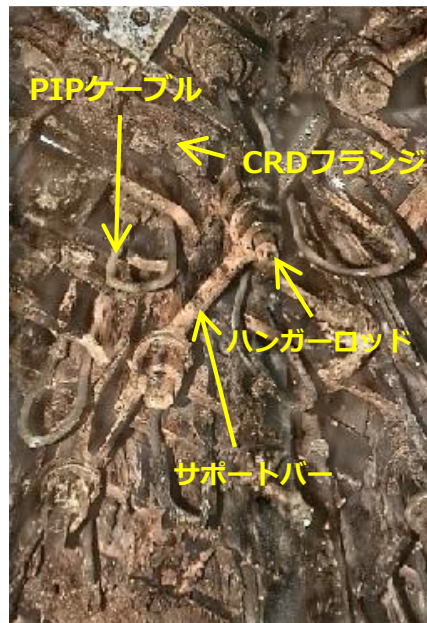
写真2. 2号機で確認されたCRD
