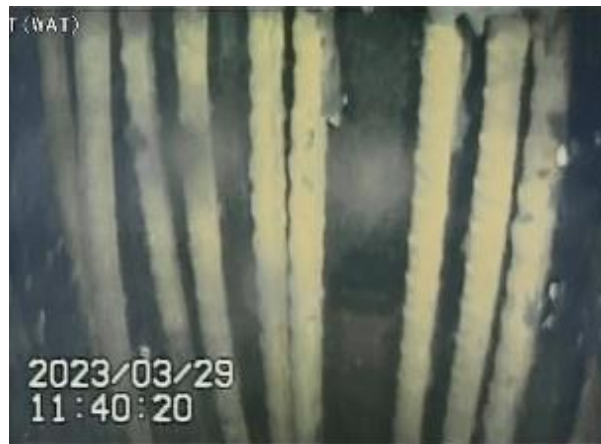
写真2. ポイント⑪下部
