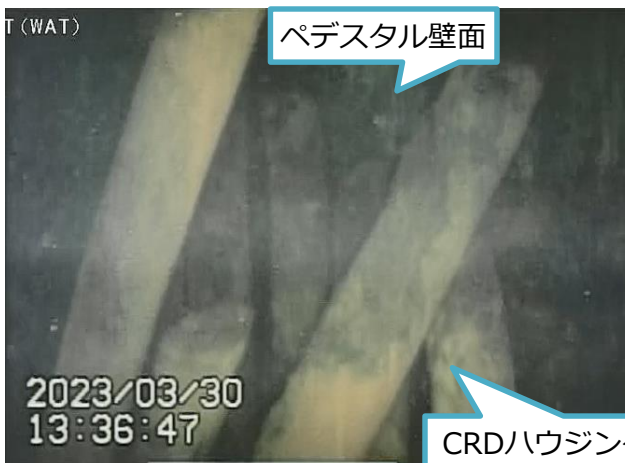
写真2. CRDハウジングと思われる構造物
