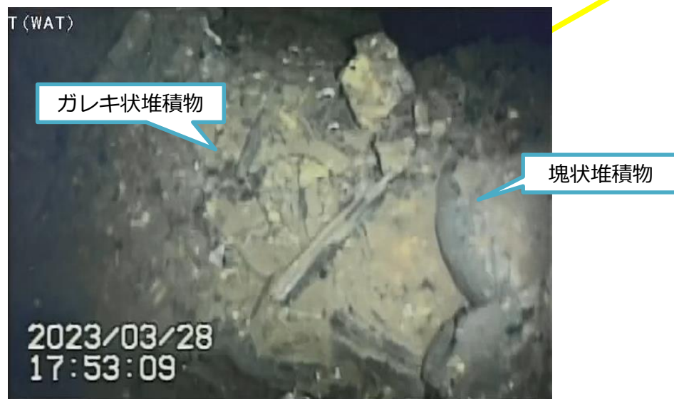
写真2. ペDESTAL内開口付近堆積物
