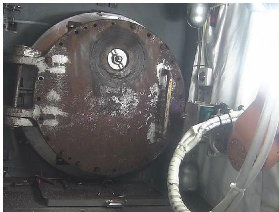
ボルト除去作業状況
