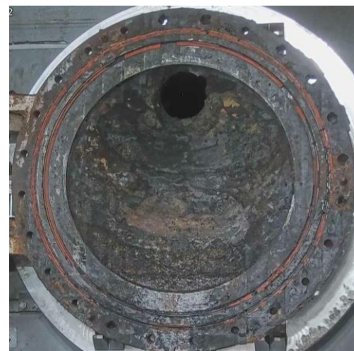
X-6ペネフランジ清掃後 (レーザ清掃)
