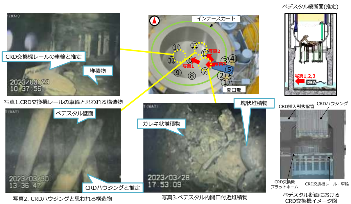
図3 ペDESTAL内底部の状態
