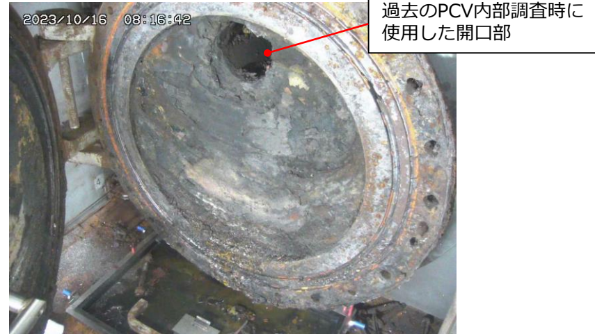
X-6ペネハッチ開放後(約90度) ※ペネを正面から見た状況
