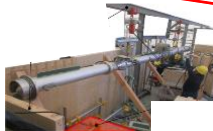
スプレイ治具設置 ※X-53ペネに接続
