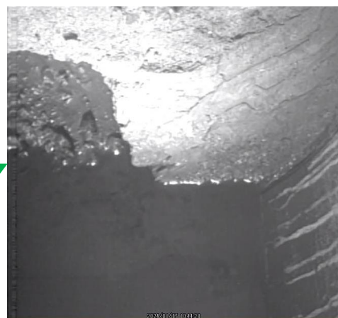
低圧水施工前 1月17日作業開始前
