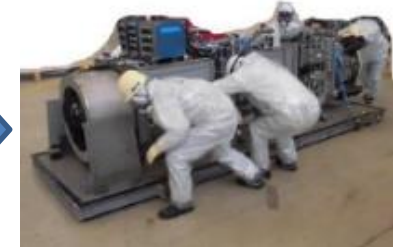
堆積物除去装置 （低圧水）撤去
