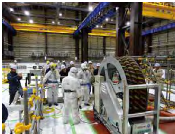
S/C脚部補強施工性確認試験
