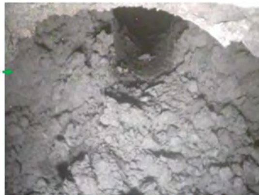
低圧水施工前 1月17日作業開始前
