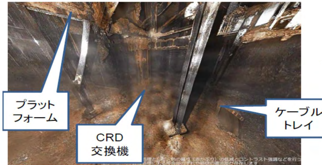
2号機 ペDESTAL床エリアの広角写真(東電HPより)
