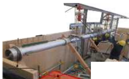
スプレイ治具設置 ※X-53ペネに接続
