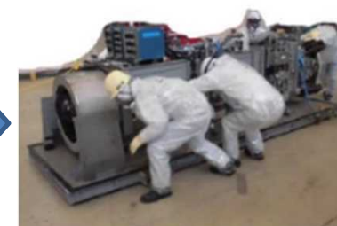
堆積物除去装置 (低圧水) 撤去
