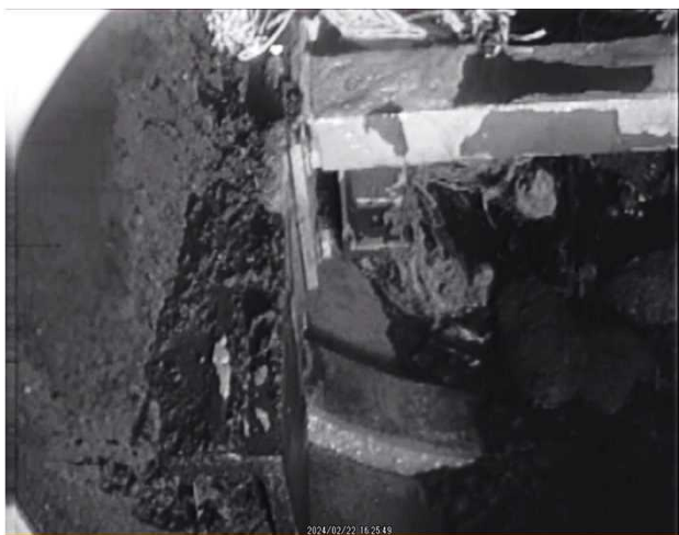
高圧水施工後（X-6ペネ左下部）
