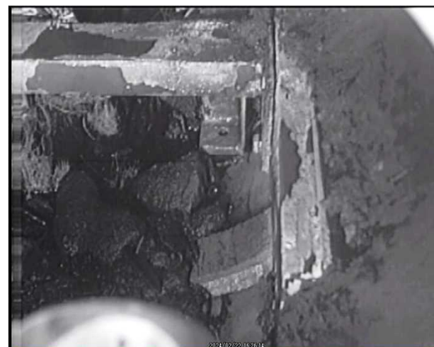
高圧水施工後（X-6ペネ右下部）
