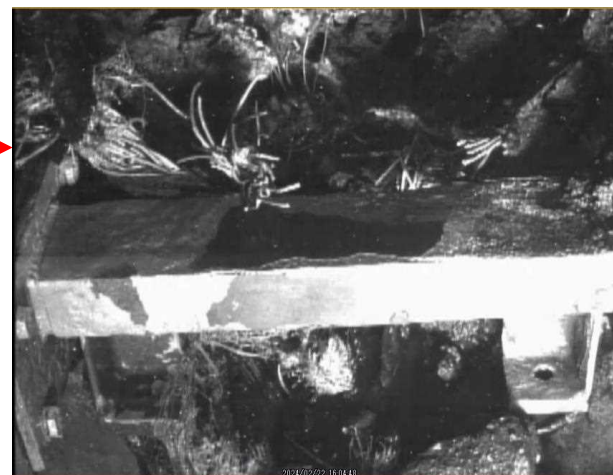
高圧水施工後（X-6ペネ中央部）
