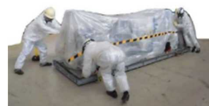
堆積物除去装置 (高圧水、AWJ) 撤去
