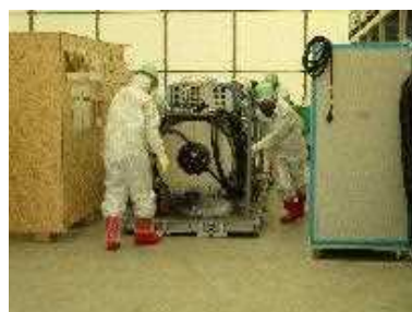
堆積物除去装置 (高圧水、AWJ) 設置
