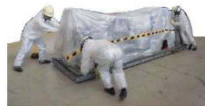
堆積物除去装置 (高圧水、AWJ) 撤去
