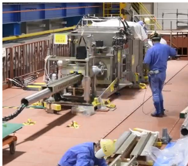
ガイドパイプの挿入
