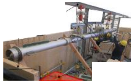
スプレー治具設置 ※X-53ペネに接続
