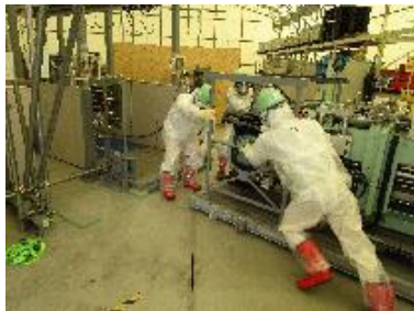
堆積物除去装置 (低圧水) 設置
