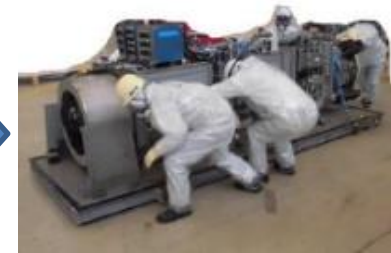
堆積物除去装置 (低圧水) 撤去
