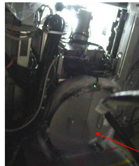
接続管をX-6ペネ接続構造に接続
