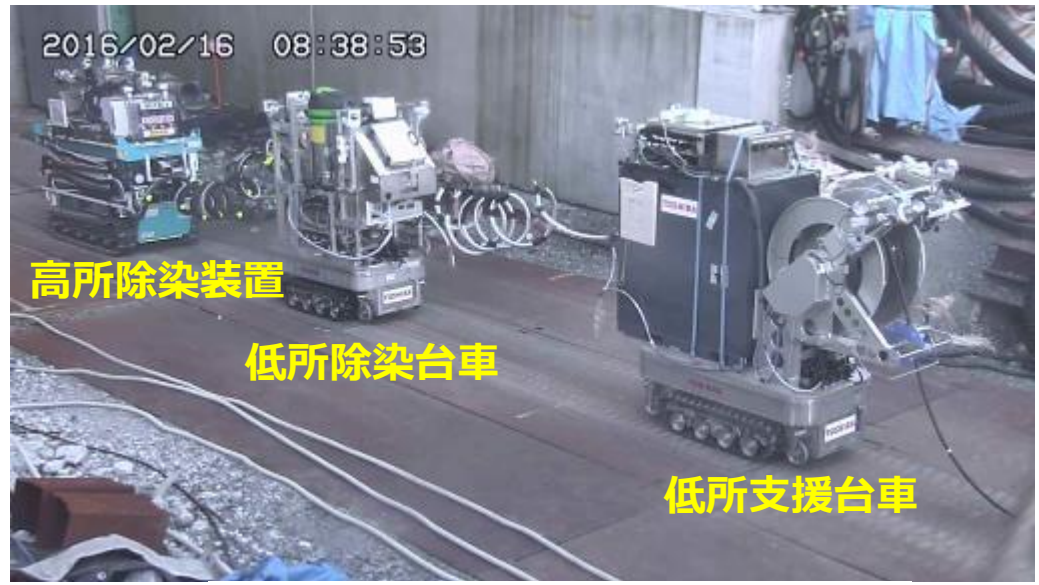
3号機R/B内への進入風景
