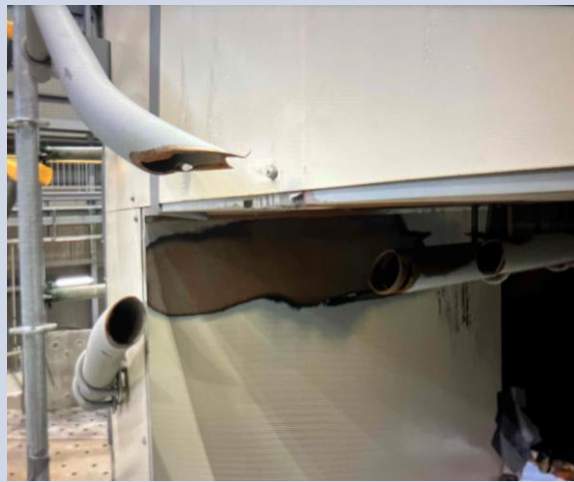
電線管撤去(C)
